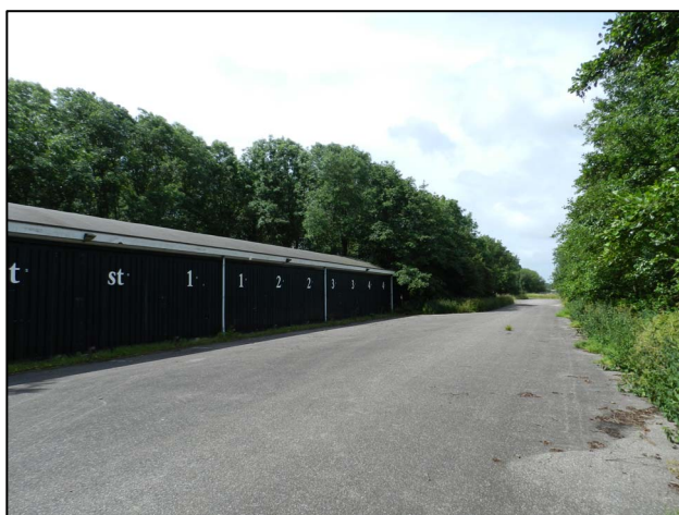
Het noordelijke deel van het MAG-terrein
