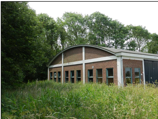
De zijkant van loods 2 waar een verblijfplaats van de Gewone dwergvleermuis werd vastgesteld.
